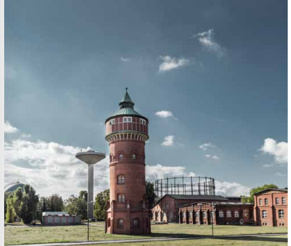
Bestandsgebäude, 2018 © Martin Miseré
