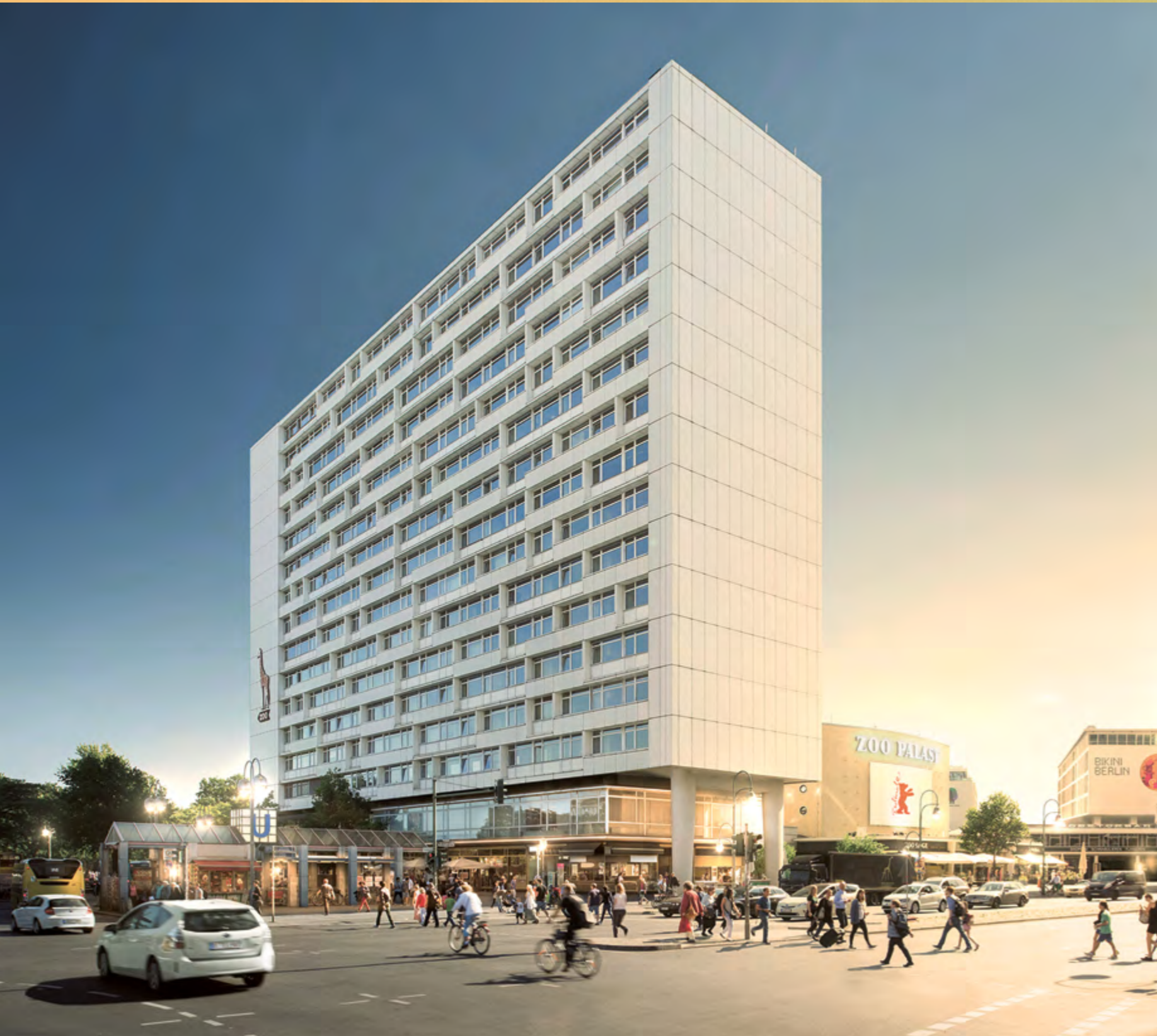
Teilsanierung im Bestandsobjekt der Bayerischen Hausbau Real Estate Huthmacher-Haus
